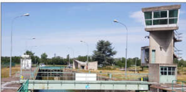
L'écluse Le Corbusier de Kembs-Niffer, l'une des « pépites » à observer sur le parcours
